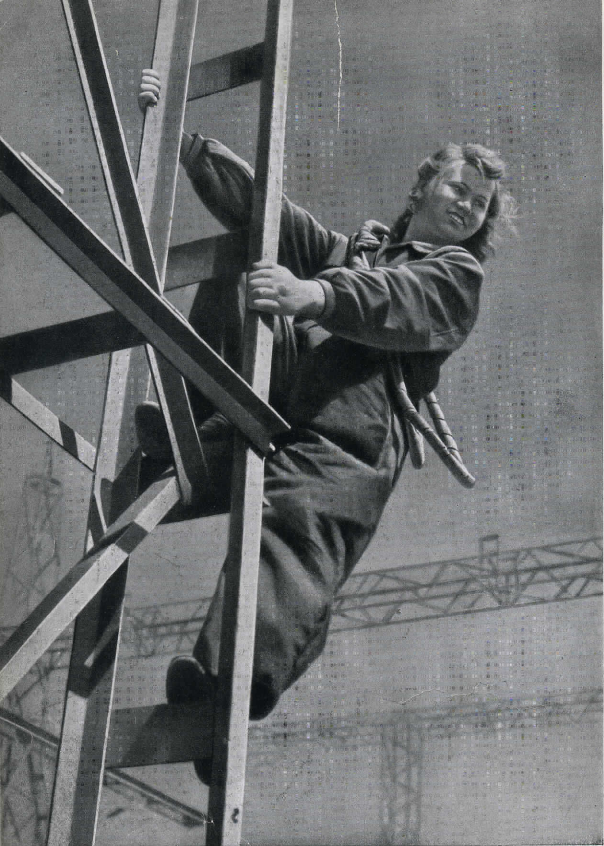
Фото 16. Н. Драчинский. На электромонтажных работах (к уроку 18)
